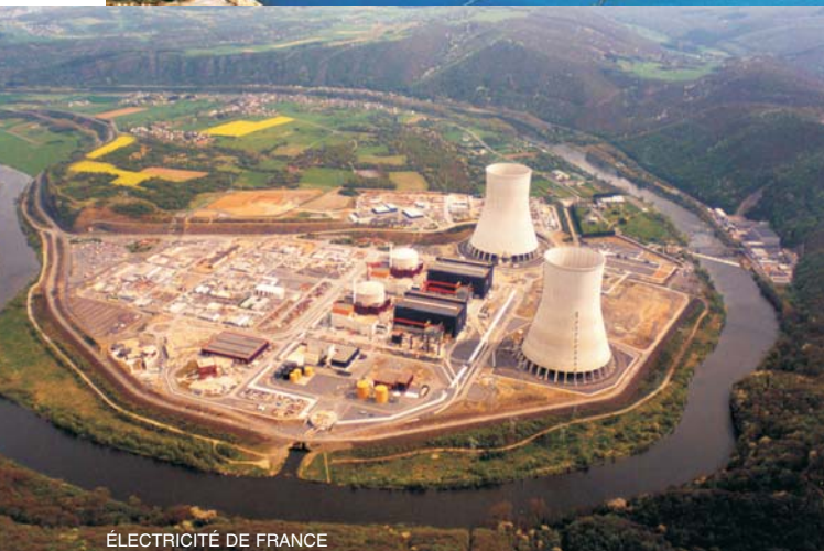
ÉLECTRICITÉ DE FRANCE
